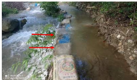
FOTOGRAFIA N°01: AFECTACION DE BOCATOMA DEL CANAL PURGA EN LA MARGEN IZQUIERDA DE LA QUEBRADA PURGA (QUEBRADA LA PURGA).
